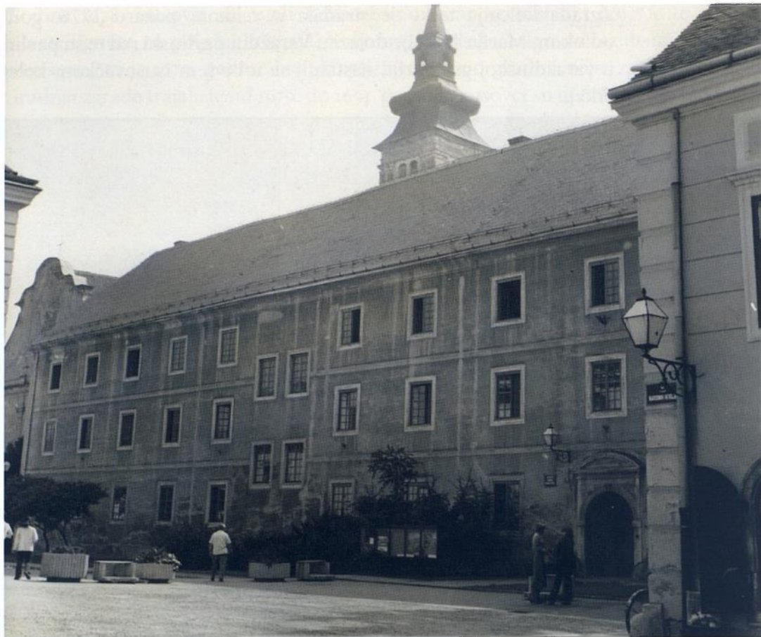
Pročelje zgrade Fakulteta
