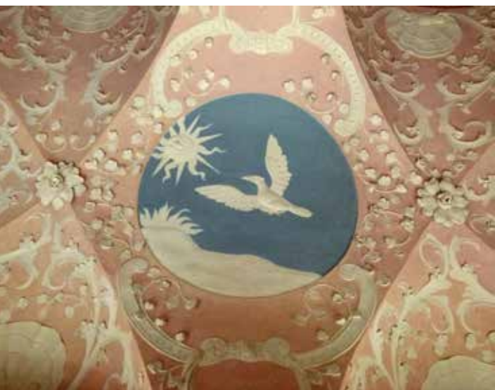
SLIKA 13. STUCCO, GOLUBICA, SJEVERNO STUBIŠTE ZGRADE FAKULTETA
